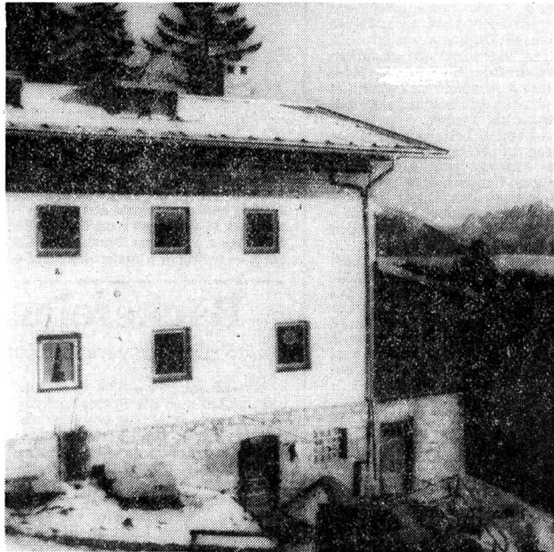
Das Brünsteinhaus wird umgebaut.
