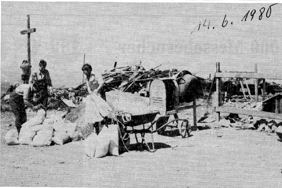
Die schwere Last, die die Mitglieder des THW von der Bergstation der Hochriesbahn zum Gipfel brachten, landete schon bald in der Mischmaschine zum Betonieren des Fundaments für den Anbau. Foto: kr
